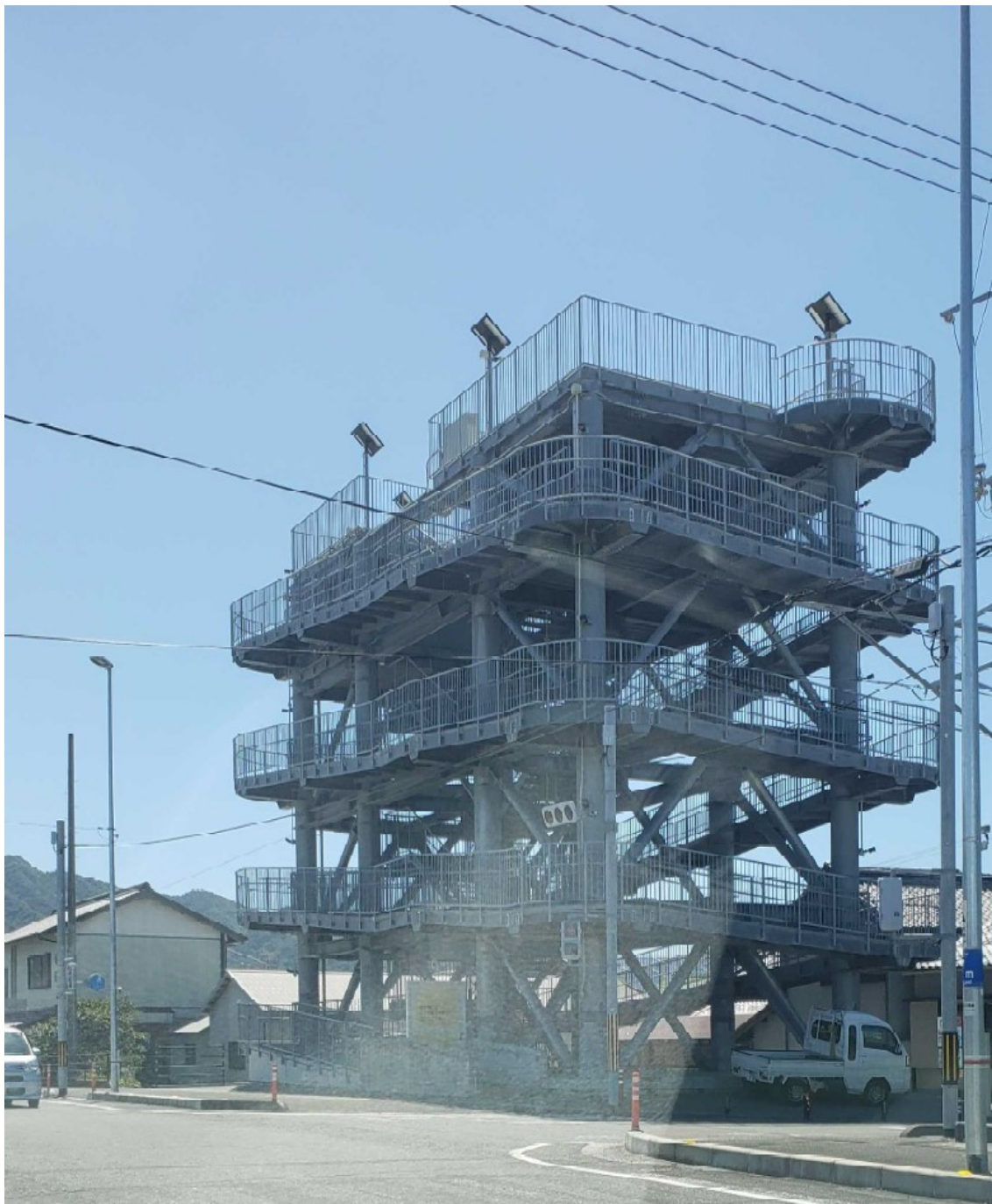
●高知の一般的な鉄骨むき出しの避難タワー
