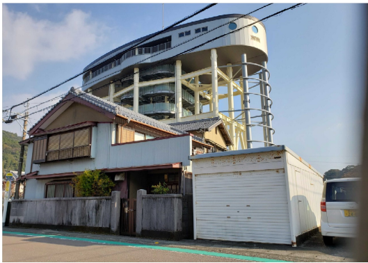
●異様な光景。佐賀地区津波避難タワーと民家
