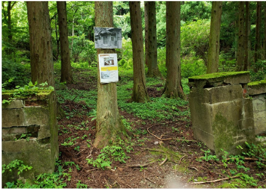
●病院跡。門柱と塀が残る
