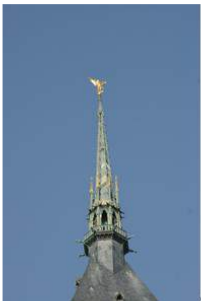
●黄金に輝く天使ミカエルを尖塔に頂く。 限られた空間のなかで重機のない時代どのような施工方法だったのか
