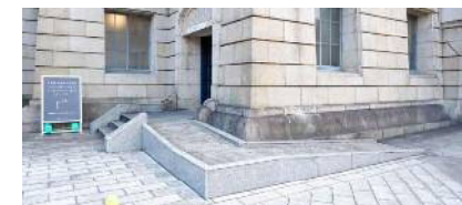
● 出入口(本堂)の傾斜路
