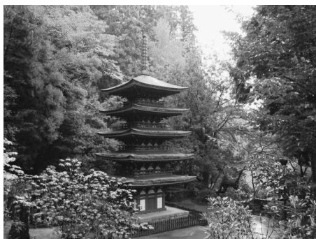
(写真1) 室生寺五重塔
