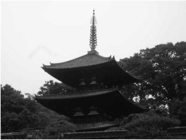
(写真9) 当麻寺西塔三重塔
