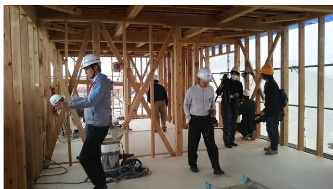
(木造事務所内部の様子)
