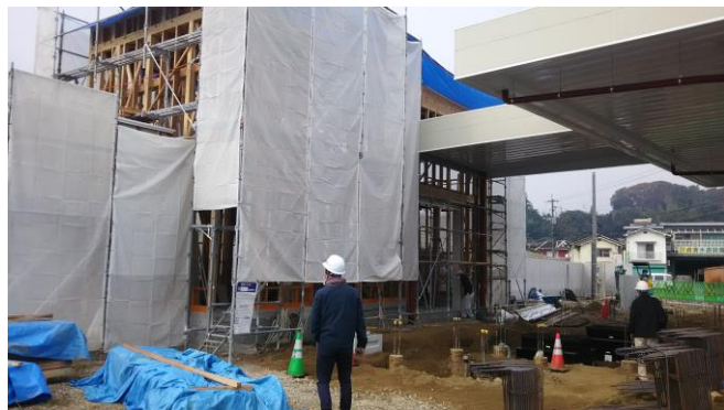
(建物の外観と工事の様子)
